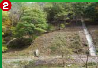
張石水路（悪沢合流点上） 斜面の上部まで真っ直ぐに作られています。【明治末施工】
