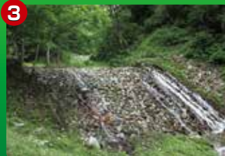
内務省2号堰堤 曲線形状のデザインが特徴です。【明治19年施工】
