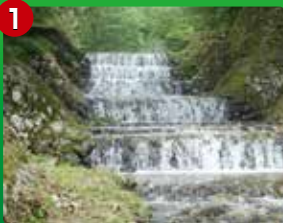
階段工上部 階段状水路。リズミカルに水が流れ落ちています。【大正7年完成】
