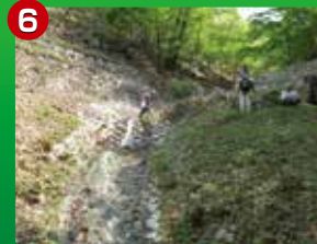
源流部の石積堰堤（日影沢） 源流まで職人の造形が続きます。【明治末施工】
