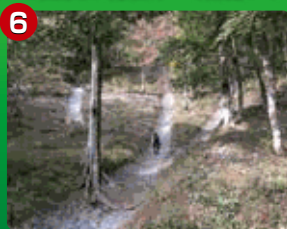
泥沢張石水路 源流まで職人の造形が続きます。【明治末施工】
